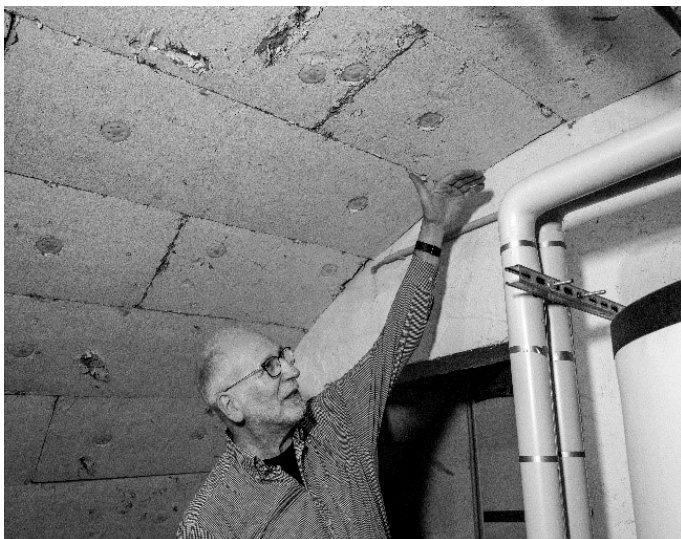
Architekt und Energieberater Bernd Nowoczyn hat sein Haus - Alt und Neubau - in einer „Gebäudehülle“ energetisch umfassend modernisiert, inklusive Gewölbekeller mit den 10 cm starken Mineralfaserplatten. Bildnachweis: Gülay Keskin
